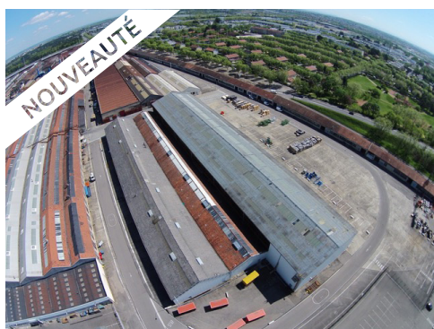
Inspection de toiture
